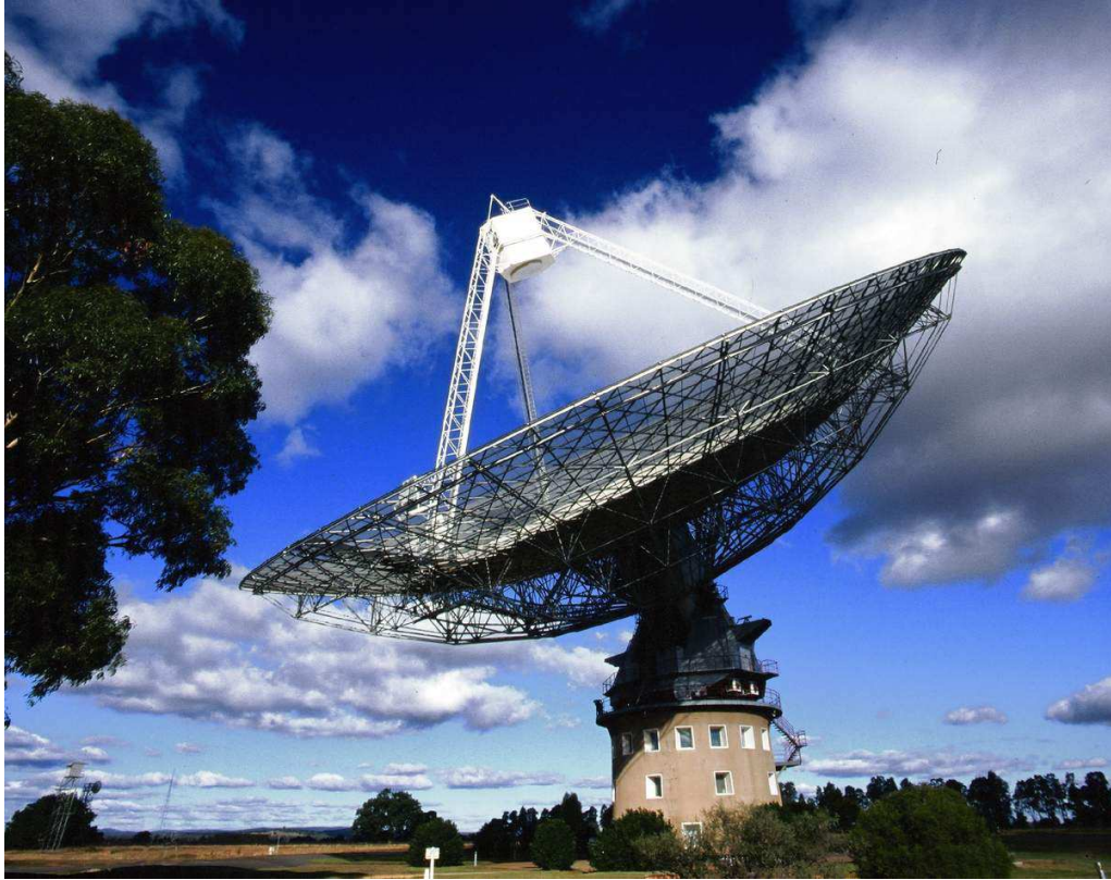
Figura 4.4: Radiotelescopio di Parkes. Diametro 64 m.
