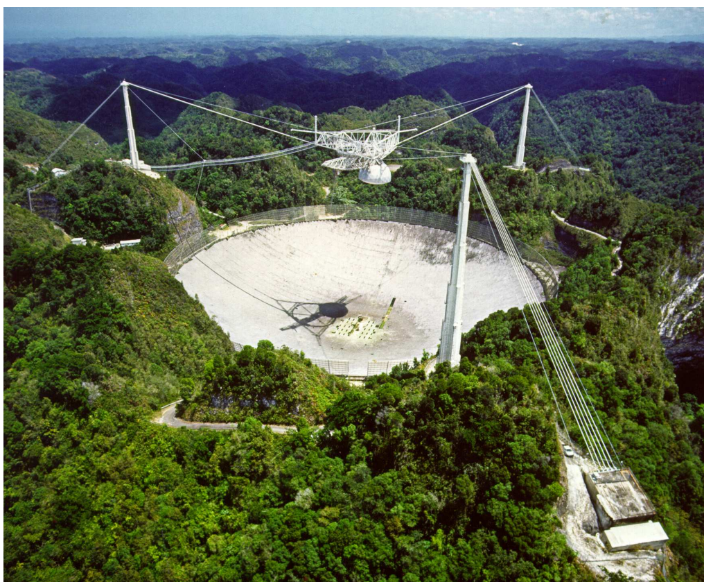
Figura 4.1: Radiotelescopio di Arecibo. Diametro 305 m.
