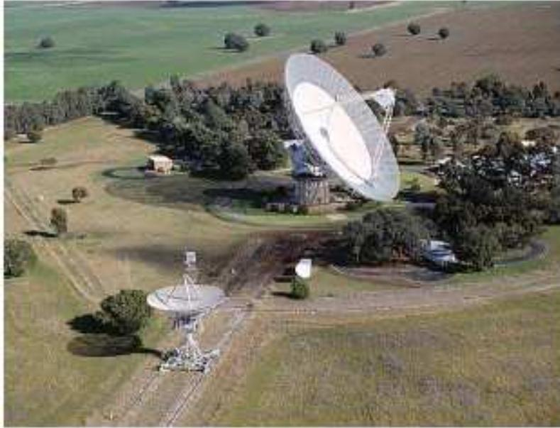
Figura 4.4: Veduta aerea del Radiotelescopio di Parkes nel nuovo Galles del sud in Australia, utilizzato per le osservazioni trattate in questo lavoro di tesi. La parabola principale è di 64 m di diametro.
